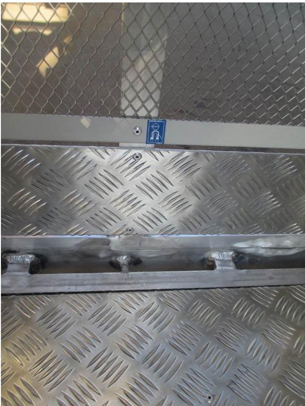
**Image 56D\_crochets d’ancrage harnais en la plate-forme fixe**
